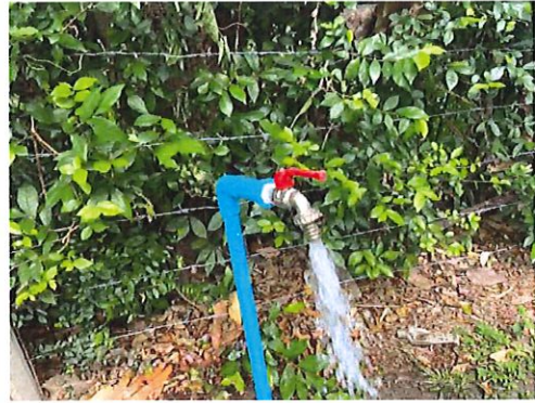
ส่งไปก๊อมน้ำด้านหลังเรือนพื้นถิ่นแม่แดง
