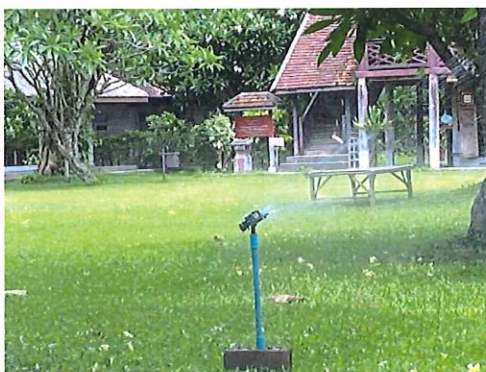
ส่งไปก๊อมน้ำที่มีอยู่เดิมภายในพิพิธภัณฑ์ต่อกับสริงเกอร์รดน้ำสนามหญ้า
