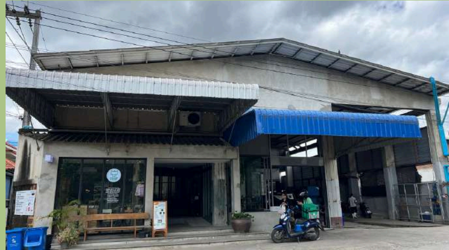
ภาพโรงน้ำแข็งซึ่งแต่เดิมเป็นคุ้มเจ้า
