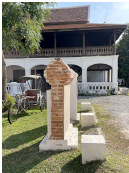
ภาพที่ 18 ภาพแสดงการเปิดไขว้ ผนังก่ออิฐและลวดลาย ของบัวพื้นเดิม
