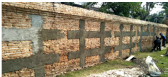
ภาพที่ 16 ภาพแสดงเสริมความแข็งแรงให้กับกำแพงด้วยการติดแผ่น GFRP (ภาพซ้าย) และ ภาพที่ 17 ภาพแสดงแนวร่องกรวดที่ป้องกันความชื้นให้กับกำแพงรั้วอิฐ (ภาพขวา)
