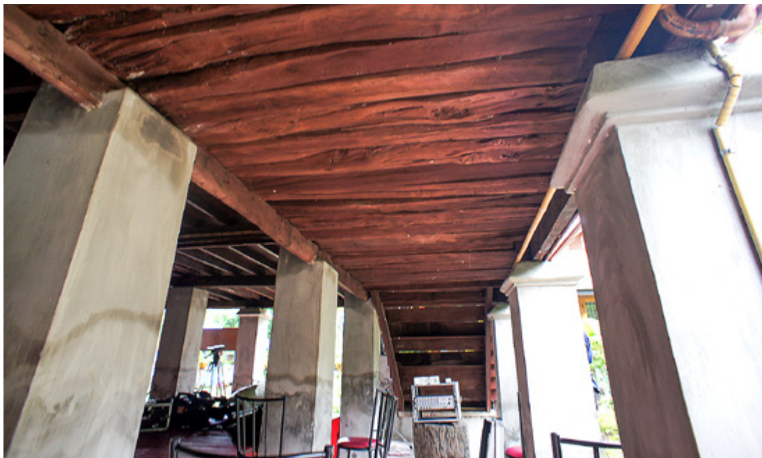
โครงสร้างพื้นค้ำเจ้ายอดเรือน ใช้ไม้แปรรูปแบบโบราณ
