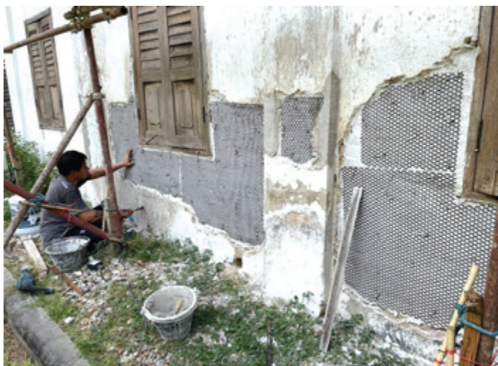
ภาพที่ 11 การกรุตะแกรงลวดตาข่ายผนังก่อนฉาบเพื่อป้องกันการหลุดร่อน
