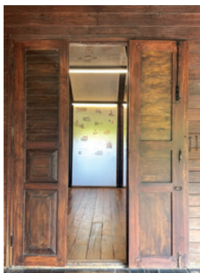
ภาพที่ 6 ประตูลูกฟักบานเปิดคู่ ตกแต่งส่วนบนเป็น “ลาย” บานเกล็ด (ภาพซ้าย) และ ภาพที่ 7 บานหน้าต่างกระจกพลิก เปิดได้ 180 องศา (ภาพกลางและภาพขวา)
