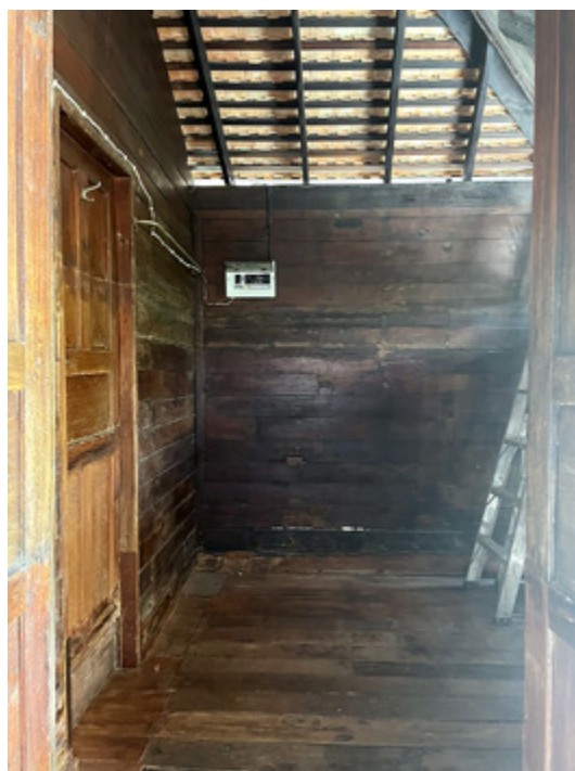
ภาพที่ 13 ภาพแสดงรื้อผนังและพื้นห้องน้ำคอนกรีตเดิมที่ต่อเติมบนโครงสร้างไม้เอก (ภาพบนก่อนรื้อผนังและพื้น ภาพล่างหลังรื้อผนังและพื้น)
