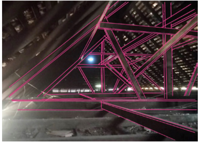
ภาพที่ 3 ภาพแสดงลักษณะสถาปัตยกรรมอาณานิคม (Colony Architecture) โครงสร้างผนังรับน้ำหนักที่ชั้นล่าง ผสานกับหลังคาทรงล้านนา (ภาพซ้าย) และภาพที่ 4 โครงสร้างหลังคาเป็นไม้ มีโครงสร้างเสริมแนวสามเหลี่ยมคล้ายโครงสร้าง Truss (ภาพขวา)
