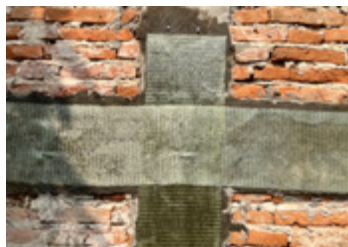
ภาพที่ 16 ภาพแสดงเสริมความแข็งแรงให้กับกำแพงด้วยการติดแผ่น GFRP (ภาพซ้าย) และ ภาพที่ 17 ภาพแสดงแนวร่องกรวดที่ป้องกันความชื้นให้กับกำแพงรั้วอิฐ (ภาพขวา)
