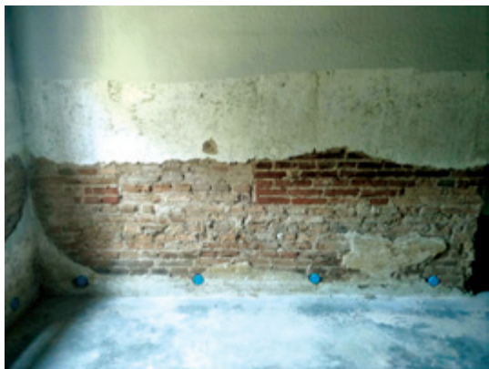
ภาพที่ 10 การฝังท่อพีวีซีเจาะรูพูนเพื่อระบายอากาศให้กับผนัง
