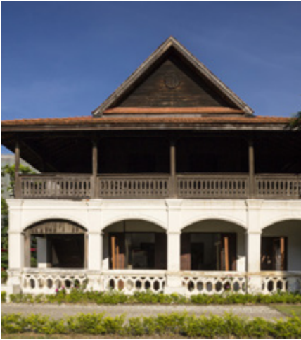
ภาพที่ 3 ภาพแสดงลักษณะสถาปัตยกรรมอาณานิคม (Colony Architecture) โครงสร้างผนังรับน้ำหนักที่ชั้นล่าง ผสานกับหลังคาทรงล้านนา (ภาพซ้าย) และภาพที่ 4 โครงสร้างหลังคาเป็นไม้ มีโครงสร้างเสริมแนวสามเหลี่ยมคล้ายโครงสร้าง Truss (ภาพขวา)
