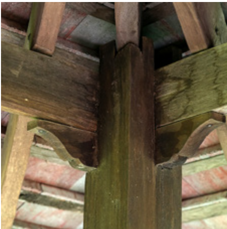
ไม้เบ่งฝาที่สุมของเรือน และการเข้าไม้ต่อไม้
