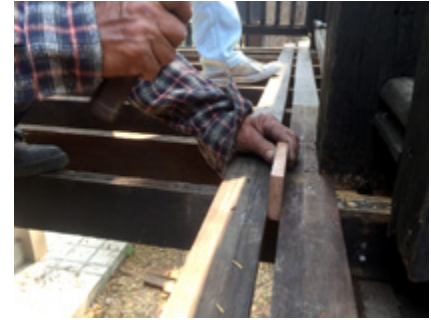
การปรับปรุงซ่อมแซมเรือนโบราณล้านนา โดยการใช้เครื่องมือโบราณ
