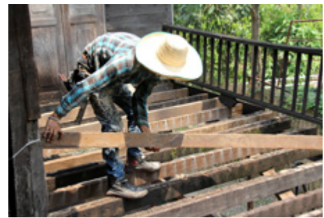
การปรับปรุงซ่อมแซมเรือนโบราณล้านนา โดยการใช้เครื่องมือโบราณ
