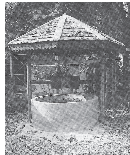
น้ำบ่อแบบมีหลังคาคลุม และมีหลุคือ กว้านสำหรับตักน้ำขึ้นมาจากบ่อ
