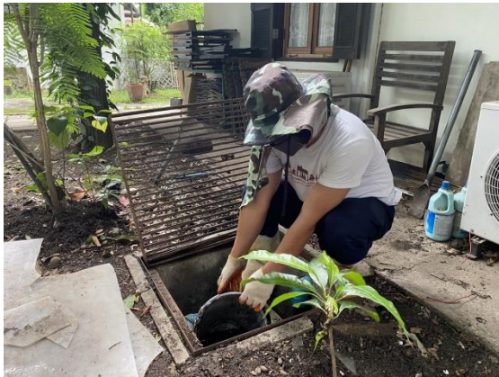
การตัดกากตะกอนไขมัน เพื่อนำสู่หลุมปุ๋ยหมักอินทรีย์
