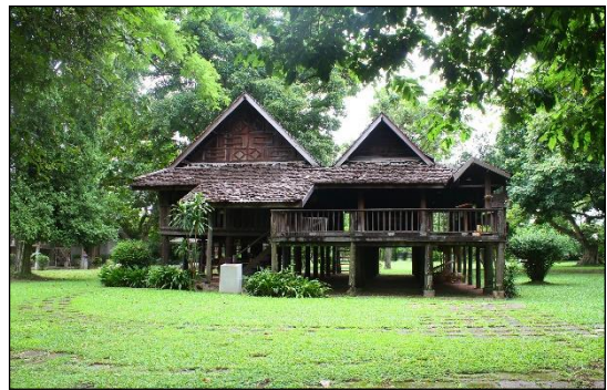
2. เรือนไทลื้อ (หม่อนตุ๊ด) สร้างปี พ.ศ. 2460
